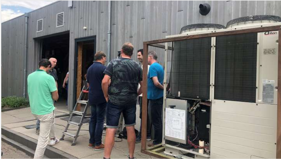
Kennismiddag gasloos sanitairgebouw bij Vakantiepark Delfse Hout
