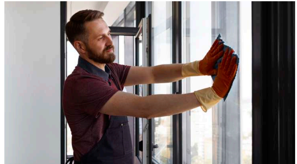
Plaatsing HR++ glas in bestaand gebouw
