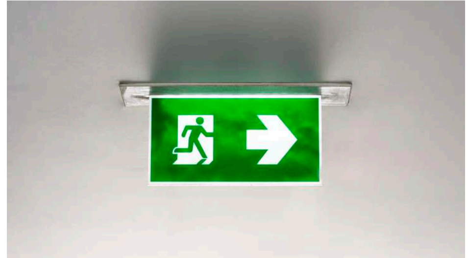
Noodverlichting, uitgevoerd met LED
